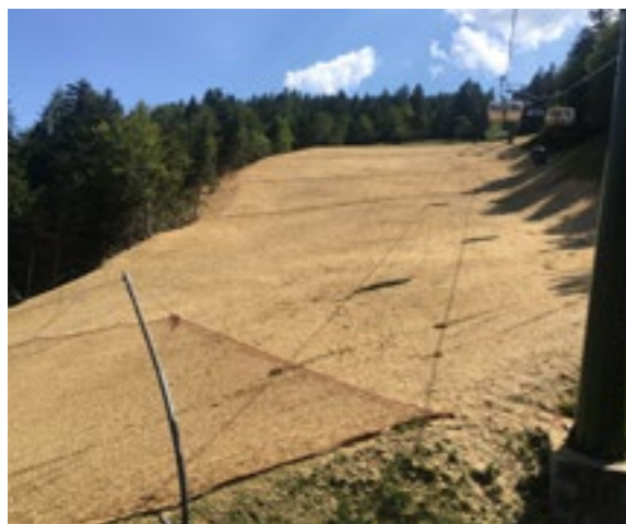
Tre fasi di preparazione della nuova pista «La Rocca». Nei due cambi di direzione più difficili, per allargare il tracciato dai meno di 20 m ai circa 40 m del nuovo progetto, è stato necessario modificare in modo significativo l'andamento originario del terreno. Sono stati effettuati sterri e riporti, che in linea di massima si sono bilanciati nella quantità di materiale movimentato
